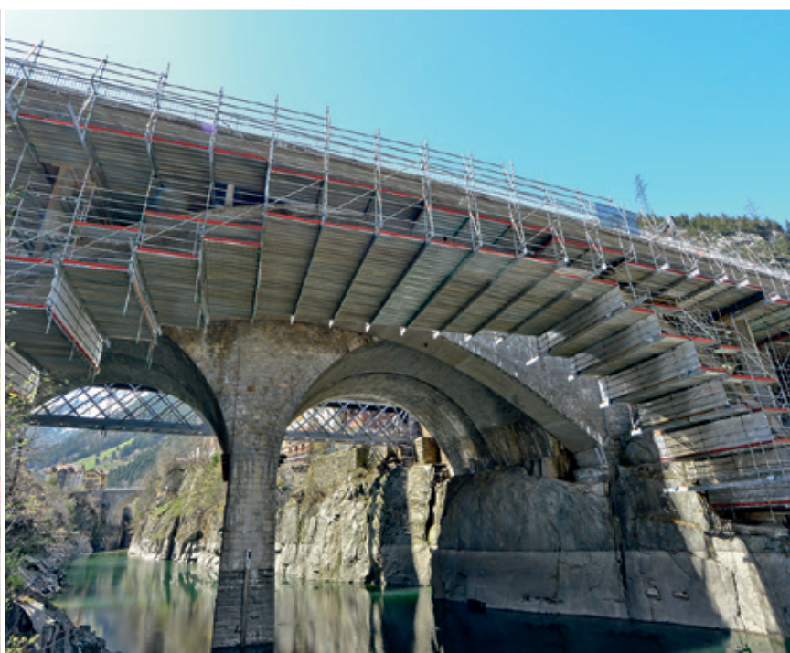
FlexBeam i integreret løsning med Allround stillads.
