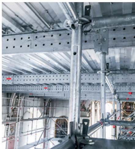
FlexBeam som fuglebursstillads
