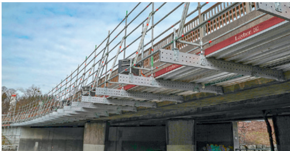
FlexBeam hængestillads til arbejde på betonkant. Afstand til underliggende vejbane overholdt
