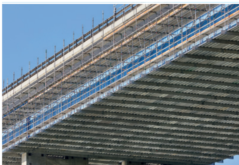
Hængestilladser med store flader med få ophængspunkter, afstivning af FlexBeam ikke nødvendig
