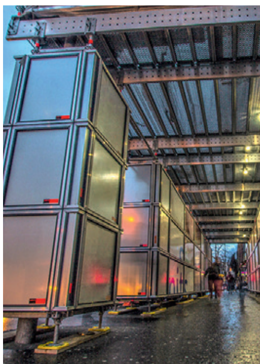
FlexBeam kombineret med Protect Kassetter
