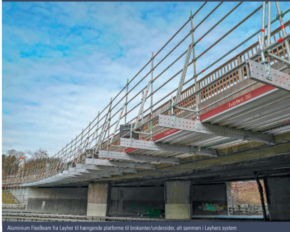
Aluminium FlexBeam fra Layher til hængende platforme til brokanter/undersider, alt sammen i Layhers system
